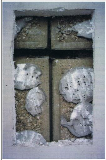
Abb. 52: Kreuzfuge mit aufgeschnittener Dämmung<sup>15</sup>
