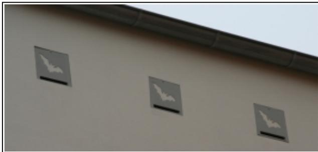
Abb. 32: In die Fassade integrierte vorgefertigte Fledermauskästen<sup>4</sup>
