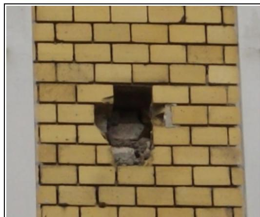
Abb. 31 - Mauerloch in Klinkerfassade (August-Bebel-Str. 10, Eberswalde)<sup>6</sup>
