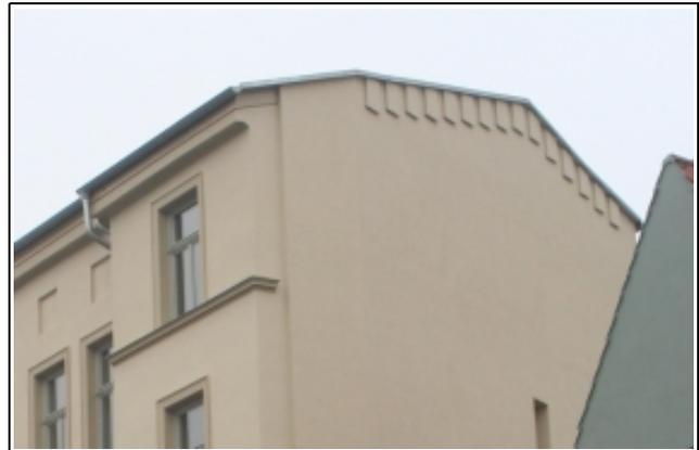
Abb. 34: Vorgefertigte Fledermauskästen an der Außenfassade - Optisch an den Gebäudetyp angepasst<sup>4</sup>
