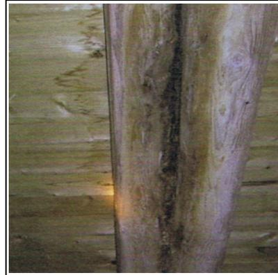
Abb. 22: Spalten schaffen zwischen parallelen Balken<sup>8</sup>
