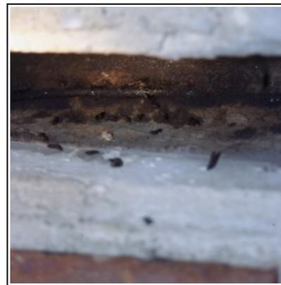
Abb. 9: Kotkrümel in einer Plattenbaufuge<sup>4</sup>
