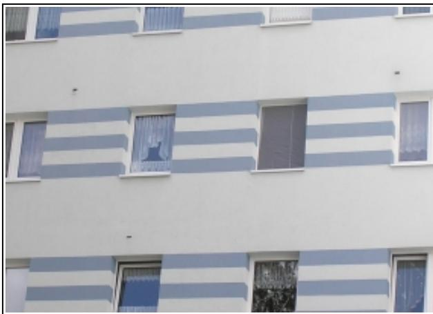
Abb. 49: Integrierte Fledermauskästen an Plattenneubauten (nur längliche Öffnungen sind zu sehen)<sup>4</sup>
